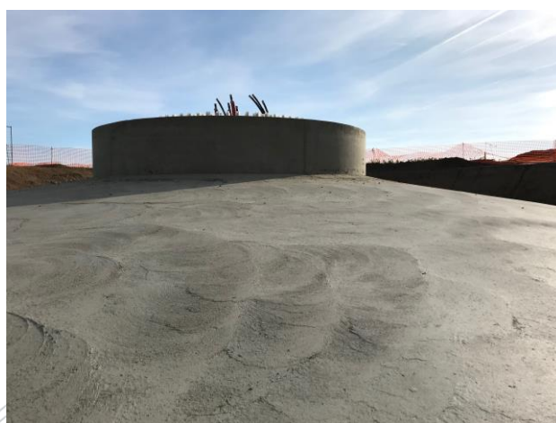
Semelle en béton coulée sur l'armature en ferraille. Source : EDPR
