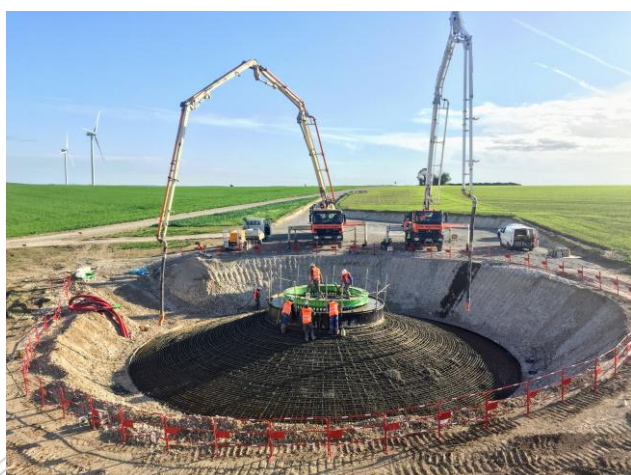
Cage d'ancrage posée sur le fond de l'excavation. Source : EDPR
